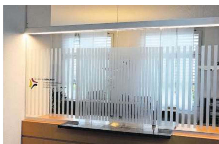
Die neue Verglasung des Schalters schützt die Mitarbeiter vor Schall und Durchzug aus der Eingangshalle. Bild: PD
